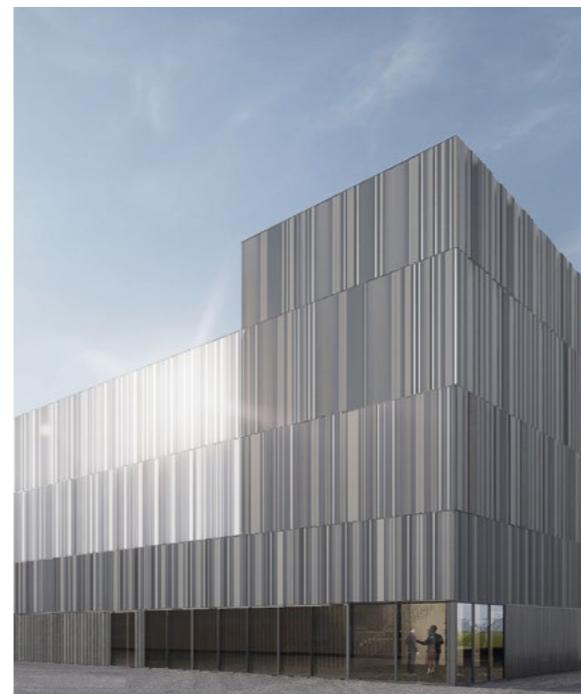
L'écriture des bâtiments unifie les hauteurs disparates sur le site, par un calepinage de bandeaux horizontaux qui recoupent un bardage acier double peau gris métallisé. Les ondes de bardage variées créent un jeu de reflets et une vibration de teintes chaudes qui s'harmonisent avec les façades des bureaux.
