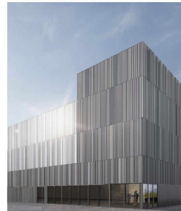
Die Gestaltung der Gebäude vereinheitlicht die unterschiedlichen Höhen auf dem Gelände durch eine Anordnung horizontaler Bänder, die eine doppelschalige Stahlverkleidung in metallischem Grau durchkreuzen. Die variierenden Profilwellen der Verkleidung erzeugen ein Spiel von Reflexen und eine warme Farbwirkung, die sich harmonisch mit den Bürofassaden verbindet.
