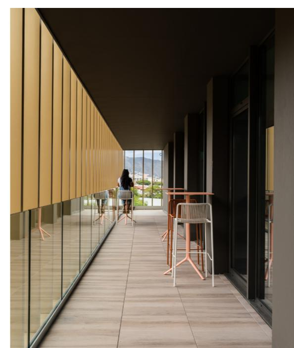
Die Büroflächen sind von einem äußeren Umgang umgeben, der durch eine zweite, perforierte Haut geschützt wird. Diese besteht aus vertikalen Metalllamellen und sorgt für Verschattung der Fassaden. Die durchgehenden Büroebenen und die großzügig dimensionierten Fensterflächen begünstigen die natürliche Belüftung der Räume.
