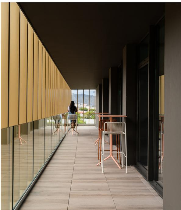
Les plateaux de bureaux sont entourés d'une coursiue extérieure, protégée par une seconde peau ajourée. Constituée de lames métalliques verticales, cette seconde peau porte ombrage aux façades. Les plateaux traversants et les baies largement dimensionnées, favorisent la ventilation naturelle des locaux.
