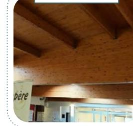
Avec plus de 305T de matière, les charpentes en lamellé collé constituent un gisement très important sur l'opération.
