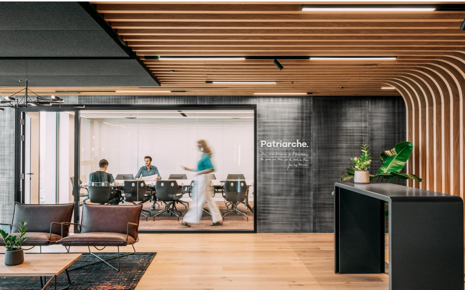
Der Schwerpunkt des Projekts liegt auf der Gestaltung von Elementen, die demontiert werden können. Das ist bei den Holzrippendecken der Fall: Sie setzen nicht nur rhythmische Akzente, sondern dienen auch als Träger für Beleuchtung, elektrische und mechanische Schnittstellen. In Paneelform lassen sie sich leicht ein- und ausbauen. Auch die Glastrennwände sind herausnehmbar, so dass die Räume im 25. Stockwerk umgestaltet oder an anderer Stelle wiederverwendet werden können.
