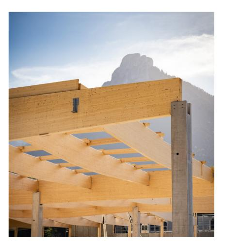
Pour assurer la stabilité de la structure, nous avons choisi d'utiliser des diagonales bois formant des poutres au vent et des palées de stabilité. La plus longue de ces poutres mesure 60m de long.
