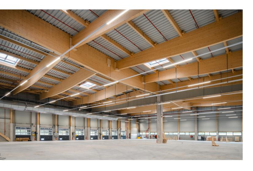
Le bâtiment, situé dans une des zones neigeuses et sismiques les plus fortes de France, a nécessité une véritable réflexion sur la structure, pour assurer la stabilité tout en assurant la résistance aux secousses sismiques.
