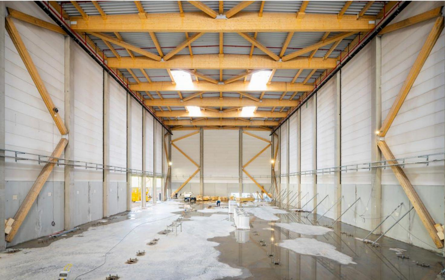
Le bâtiment est situé dans les zones neigeuses et sismiques les plus fortes de France métropolitaine. Cette localisation implique des efforts plus importants sur la stabilité de l'ensemble pour supporter de fortes charges et résister aux secousses sismiques.
