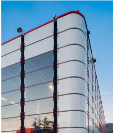
La réhabilitation concerne principalement le traitement des façades. Il s'agit, tout en reprenant l'écriture originale de l'architecte, d'inclure des améliorations techniques en termes de déstratification de l'air et de mise en sécurité des installations existantes. Il ne s'agit pas pour autant de faire fi des progrès dans le domaine des matériaux, vitrages, panneaux métalliques, qualité des poudres de peinture et protection à la corrosion qui apporteront une pérennité supplémentaire.
