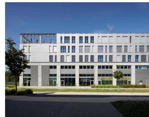
Le projet comporte deux ailes de 5 niveaux disposées parallèlement sur un axe Nord/Sud. Elles dessinent une rue centrale servant de voie de livraison pour les ateliers situés en rez-de-chaussée.
