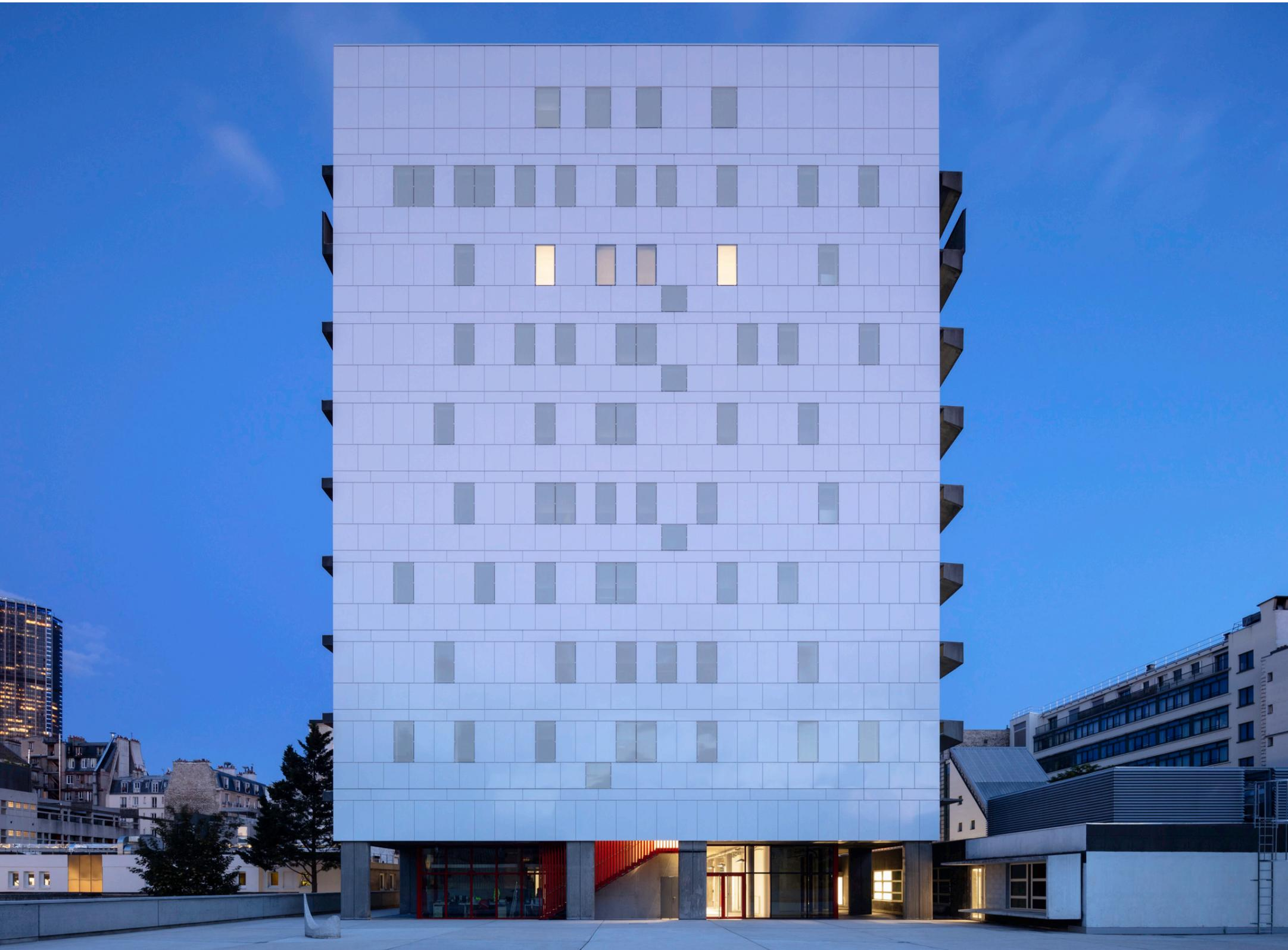
Nous avons simplement percer le pignon sur la trame d'origine et composer un ensemble de panneaux vitrés à dominante blanche, plus au moins opalins allant du transparent à l'opaque.
